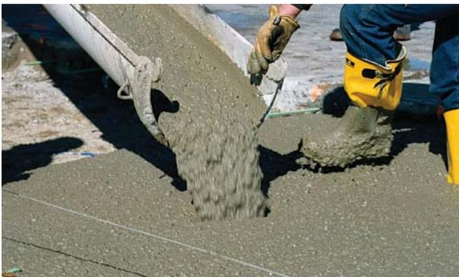
ASR debido al uso inevitable de agregados reactivos. El aditivo ASRX 30LN convierte la sílice reactiva que se encuentra en el agregado en un material no expansivo, no destructivo.
