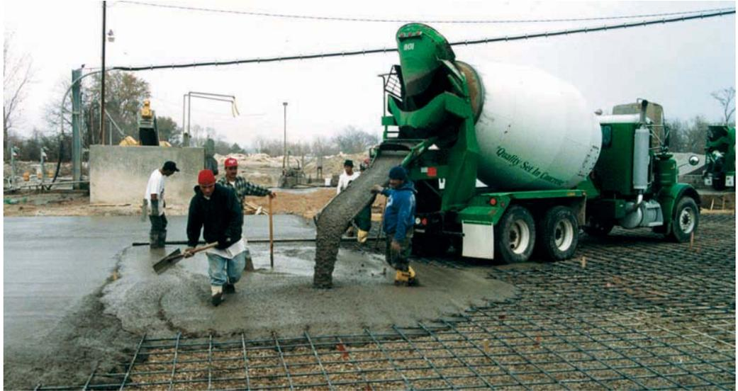
El concreto auto-compactable (Self Consolidating Concrete SCC), fue incorporado a la industria del concreto a finales de la década del 80. El uso de SCC en los EE.UU. ha sido facilitado por la inclusión de los aditivos reductores del agua de alto rango de tercera y cuarta generación, o llamados también superfluidizantes o hiperplastificantes, tales como los aditivos RHEOBUILD® y GLENIUM®, que incrementan notablemente la fluidez y facilidad de trabajo del concreto.
