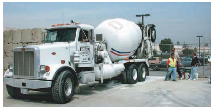
Camión premezclado completamente cargado sobre una losa con Concreto 4x4, 4 horas después de colocación
