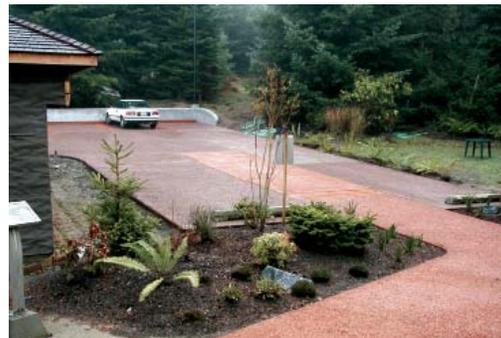
el tamaño de agregado y la densidad lograda en la mezcla, pero puede caer en un rango de 81 a 730 Litros por minuto, por cada m<sup>2</sup>.
