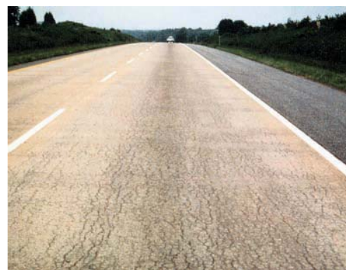
Figura 1. Resquebrajamiento en pavimento inducido por ASR
