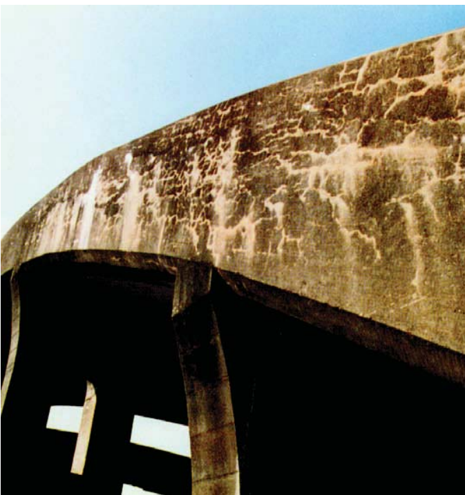
Figura 2. Gel de ASR y agrietamiento en Puente en arco.
